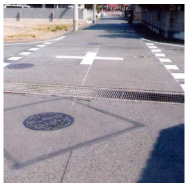
交差点内の停止線の改善
