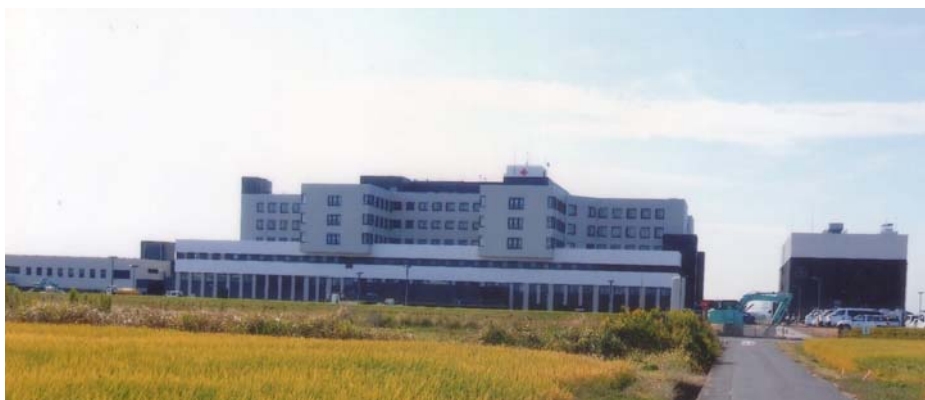
工事が進む前橋赤十字病院(2018年春開院予定)
